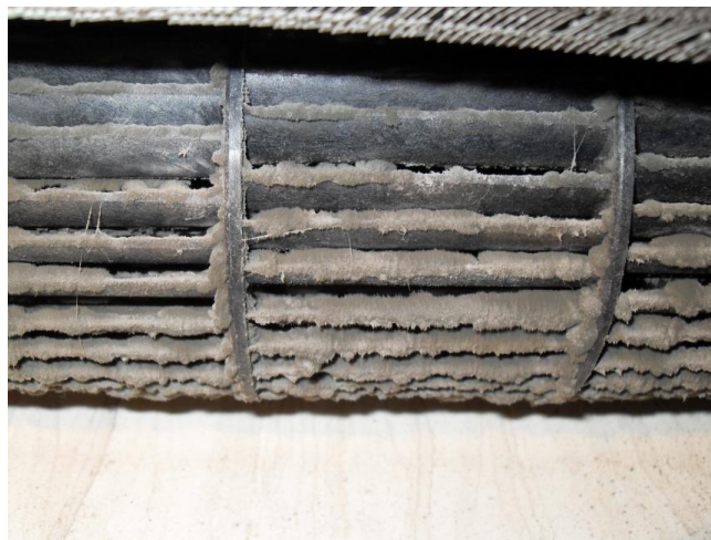
Fig. 1 Stato di una ventola sistema di condizionamento
